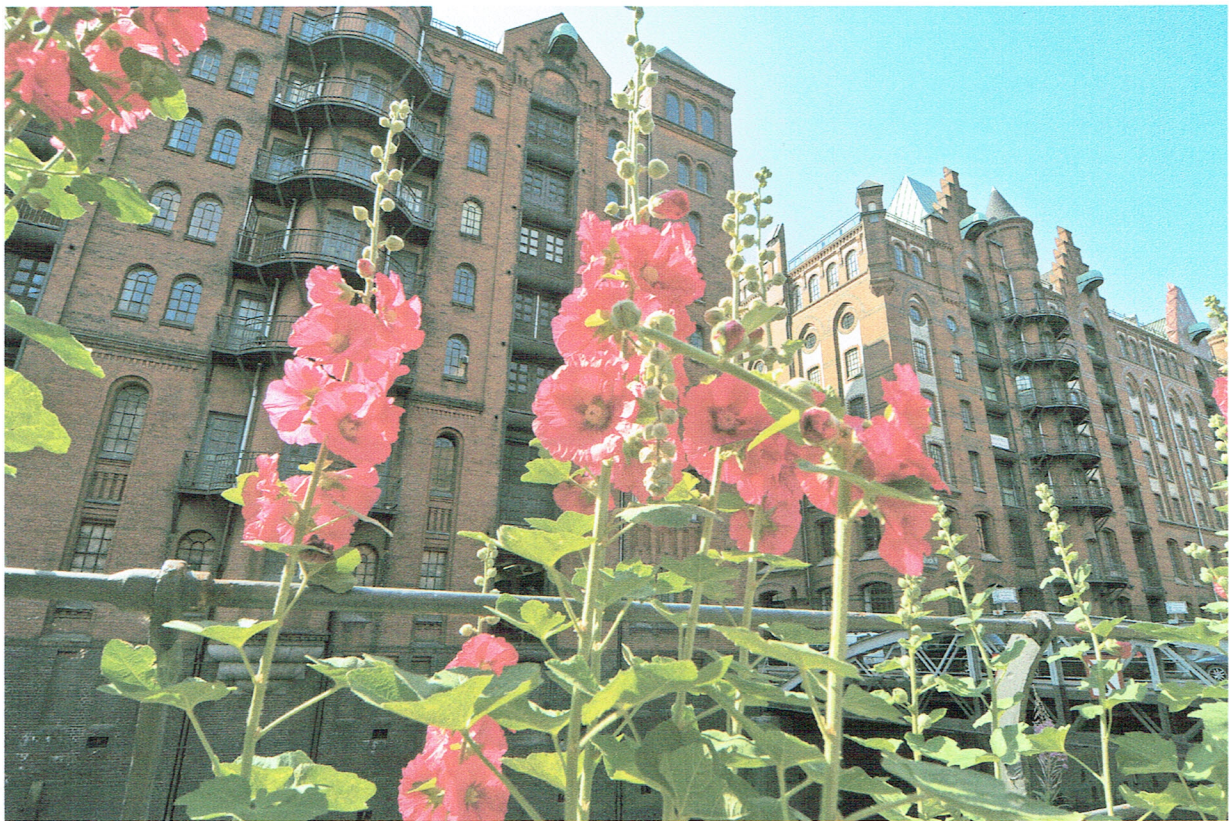
Speicher am Holländischbrookfleet, vor der Sanierung / Foto: Matthias Krüttgen
