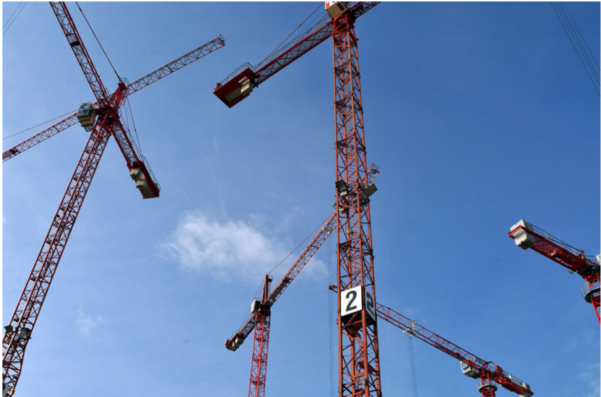
Baukräne Hafencity, Dauerbaustelle Überseequartier / Foto: Matthias Krüttgen
